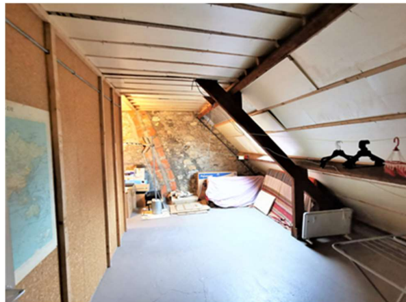
Un espace à aménager au 2 e étage
